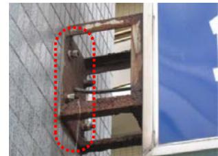
アンカーボルトや取付部プレートが腐食または変形していないか。
