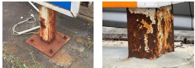
支柱、ベースプレート、アンカー等にさびが発生または腐食が進行していないか。
